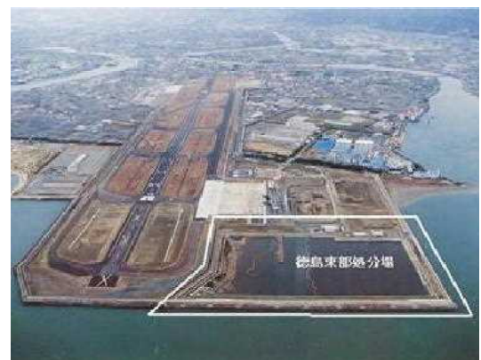
徳島東部処分場（管理型最終処分場）
